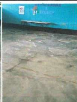
Foto 3: Se evidencia el mal estado del piso en las aulas del establecimiento por lo que es necesario sustituirlo por uno de mejor calidad
