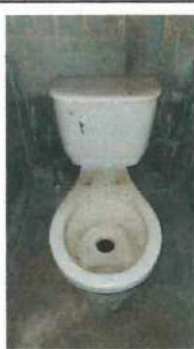
Foto1: El deterioro y fugas internas, es la causa por la que hace varios años no han sido utilizados, siendo urgente la sustitucion y reparacion de 5 servicios sanitarios de niñas y niños
