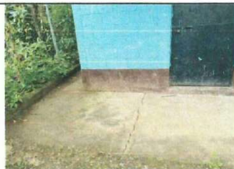
Foto 6: La losa del corredor se encuentra dañada por lo que se necesita sustituirla
